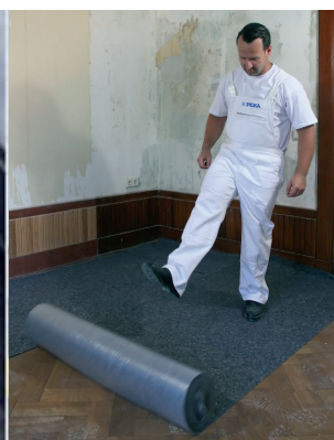
Der komplette zu schützende Untergrund wird abgedeckt...
